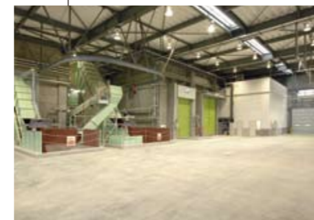
プラットフォーム 施設へ運びこまれたごみを、ここから投入扉を通してごみピットに投入します。
