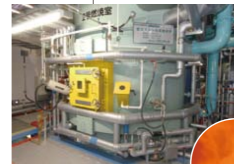
焼却炉 焼却炉の下方から高温の燃焼空気を均一に供給し、ごみを安定燃焼させます。
