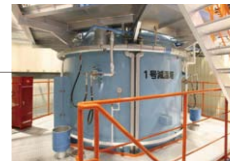
減温塔 高温の燃焼ガスを自動制御の水噴霧により、急速に冷却します。
